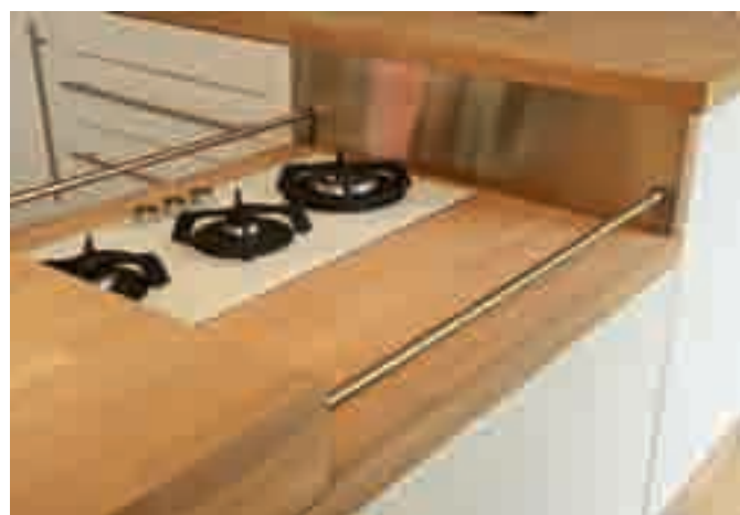
Die Gas-Rechauds befinden sich unter dem ausziehbaren Küchentisch.
