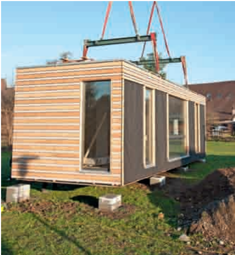
Ein Pneukran platzierte den Bau auf vorbereitete Fundamente. Fotos T. Schindler und S. Hartmann
